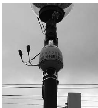
街路灯に設置した防犯カメラ
